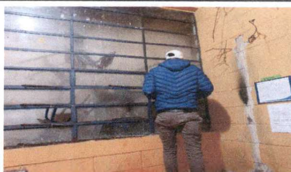
Foto 6: Sustitucion de vidrios de ventanal de cocina
