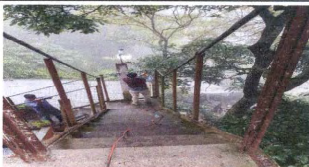
Foto 4: Sustitucion de baranda de metal de gradas de la cancha del establecimiento
