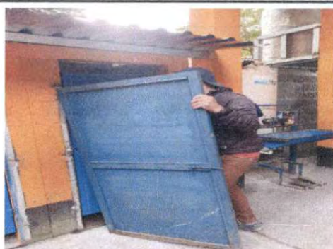
Foto 4: Sustitucion de 1 puerta servicio Sanitario de niños del centro educativo
