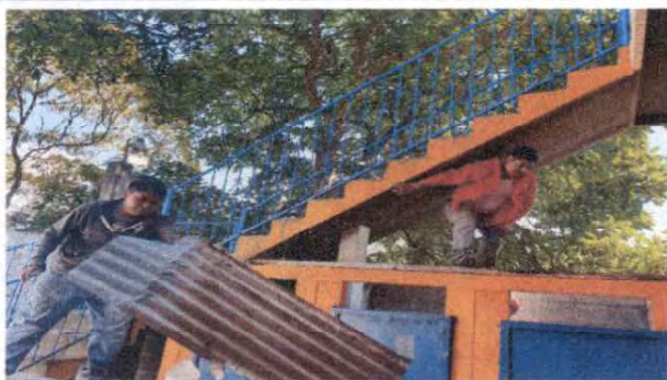
Foto1: Sustitución de lámina, por lámina troquelada aluzinc calibre 26 de servicios sanitarios de niños y niñas
