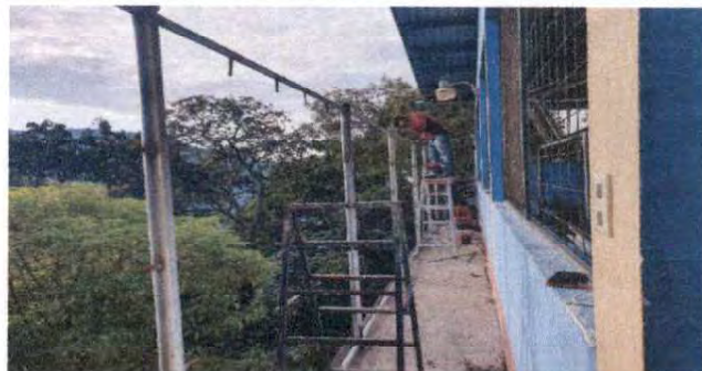
Foto 6: Sustitucion de muro perimetral con tubo HG y malla galvanizada de la cancha del establecimiento
