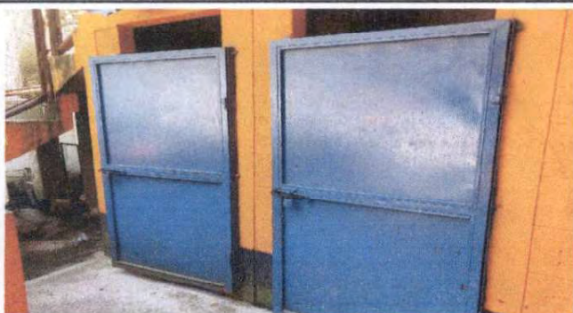
Foto 3: Mantenimiento a estructura (lijado, cambio de tubo , cepillado, sujeciones, aplicación de pintura) de 2 puertas de servicios sanitarios de la escuela
