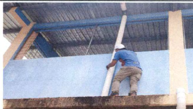
Foto 2: Reparación de bajada de agua, tubo PVC 3" de la cancha del establecimiento
