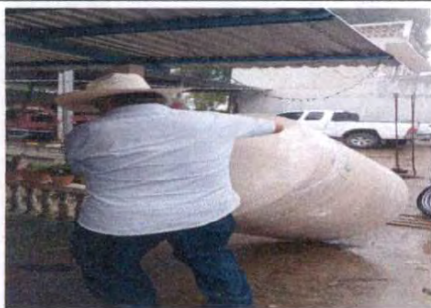
Foto1: Sustitucion de deposito de agua 1,000 lts. Instalado pasillo lado derecho del establecimiento
