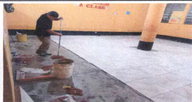
Foto1: Sustitucion de piso ceramico 2 aulas, direclon, bodega y cocina
